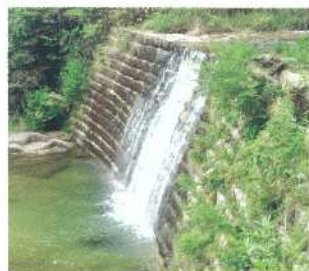
石積みアーチ構造のオランダ堰堤
