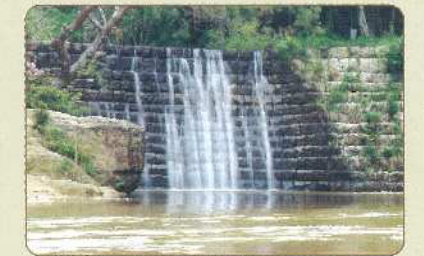
デ・レーケのもと、田辺義三郎が設計・施工監督を行ったオランダ堰堤。今も砂防の役割を果たす。
