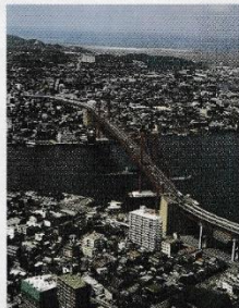
写真-② 工事完成後の若戸大橋
