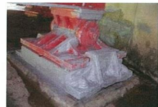
写真9 防食テープ施工完了
