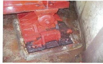
写真6 重曹ブラスト施工完了
