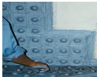
添接板のボルトに貼付け
