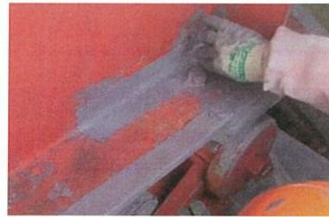
写真8 防食テープ施工状況
