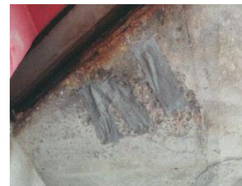
RC床版の下面に貼付け
