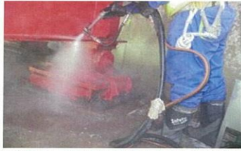
写真5 重曹ブラスト施工状況
