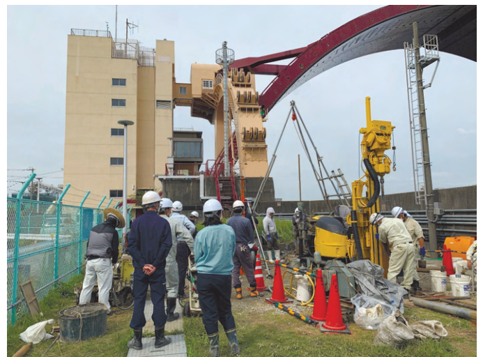
港区弁天6（安治川水門）での地盤調査の様子
