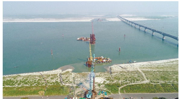
河川範囲 (右岸) 既設橋、 対岸では なく中洲
