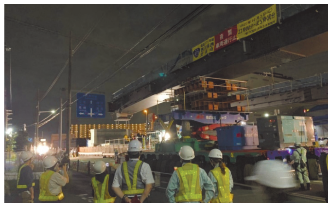
写真3 ぶら土木 茨木亀岡線橋梁架設工事 （2021.09）
