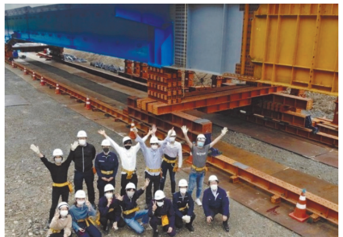
写真 3 ぶら土木 湯浅御坊道路送出し架設 （2020 年 6 月）
