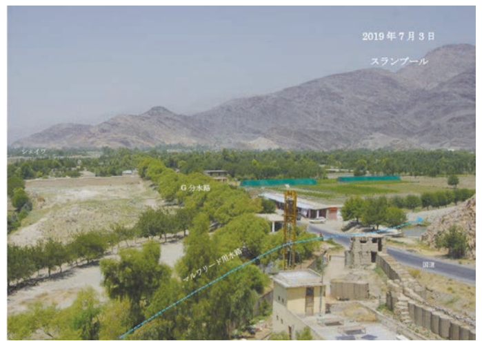
マルワリード用水路建設後の緑地
