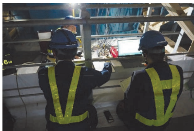
写真3 夜間実橋載荷試験における計測状況 (2020年4月)
