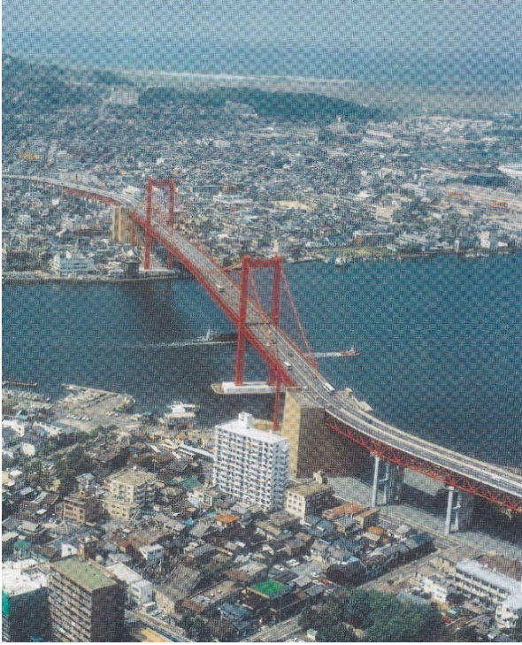
【4車線拡幅工事後の完成写真】
