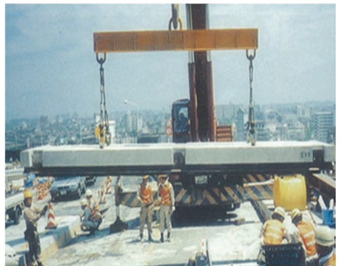
【プレキャスト RC 床版の設置】
