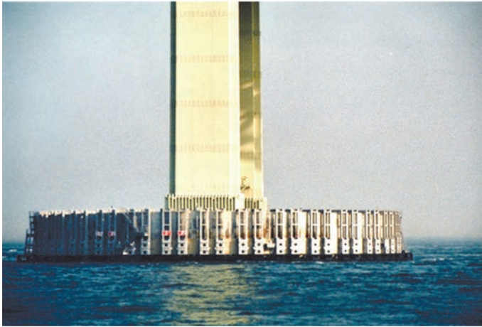
写真4 明石大橋円形橋脚に実装された船舶衝突緩衝工
