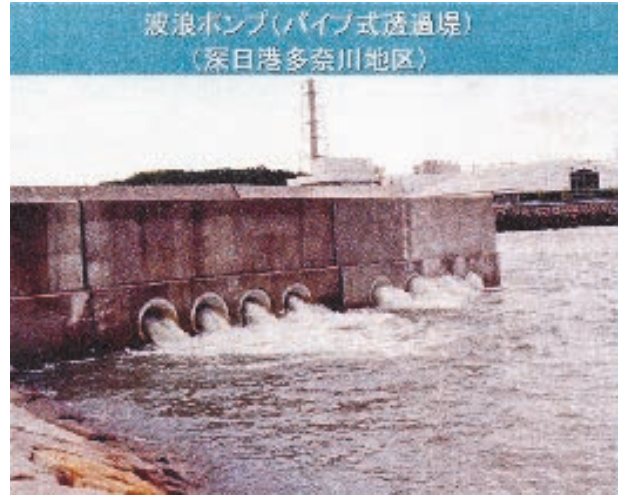
写真5 大阪府深日港多奈川地区漁港に実装されたパイプ式透過堤
