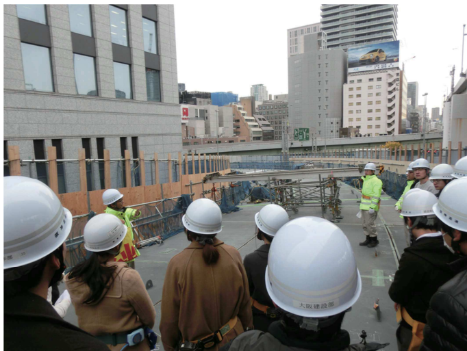
写真6 ぶら土木 阪神高速西船場ジャンクションの現場見学 (2018年11月)
