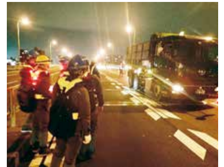
阪堺大橋における夜間計測
