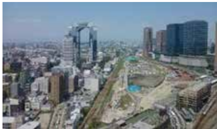
うめきた2期区域、南側より撮影 (平成29年8月)
