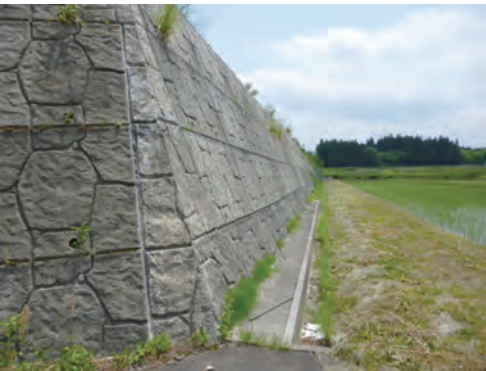
新潟県上越市の高速道路の法止めのブロック積み擁壁（ケイコンの製品）
