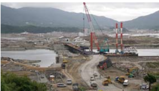
写真-3 施工中の気仙大橋仮橋設置工事 (岩手県陸前高田市)
