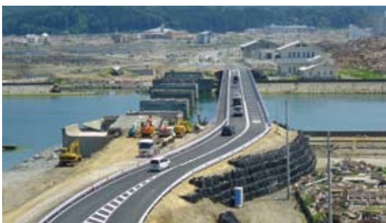
写真-4 完成した気仙大橋仮橋 (2011年7月10日開通)
