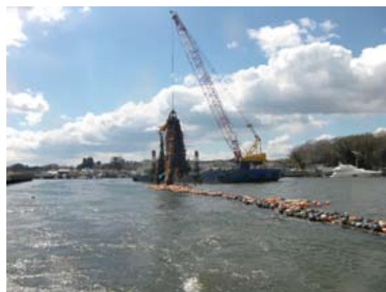
写真-1 仙台塩釜港 (塩釜工区) 啓開作業 (宮城県)
