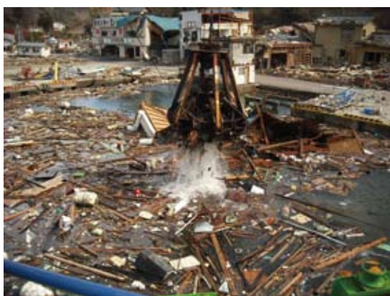
写真-2 志津川漁港啓開作業 (宮城県)
