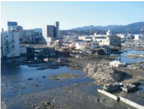
気仙沼港：水揚げ場背後の復旧状況
