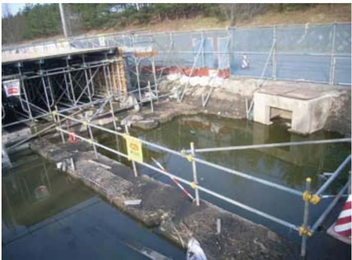
震災による被災状況 ～掘削箇所が津波により水没（人的被害は無し）～
