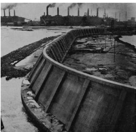
躯体が完成した当時の防潮堤
