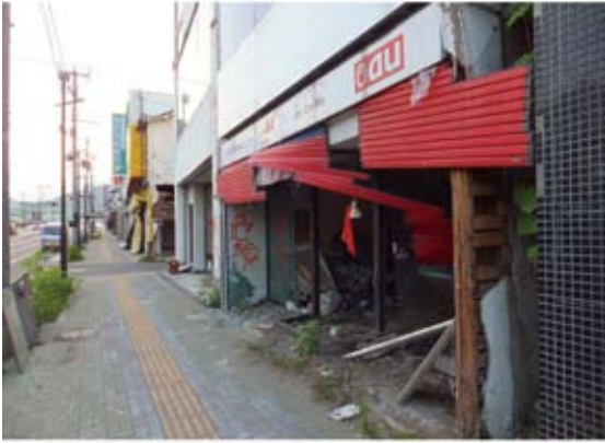
写真-1：被災した釜石の商店街（H23年8月）
